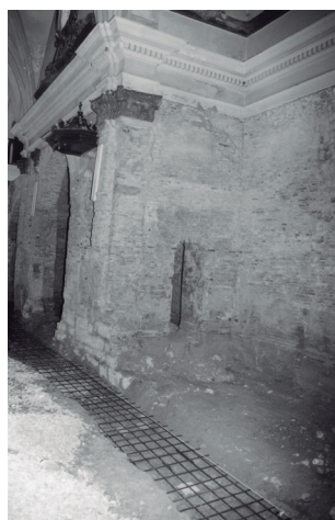
Izquierda y arriba: interior de la iglesia durante las obras de reparación (1998 ). (Fuente ANB)
