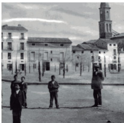
Torre apuntalada (Fuente: ANB)
